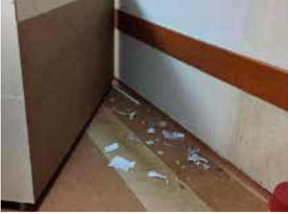
Acil servis kontamine alanlarından bir görünüm
