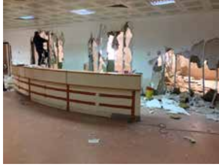
Oda oda bölmelere ayrılmış eski acilimizin arena tipi acile dönüşmesindeki yıkım anı.
